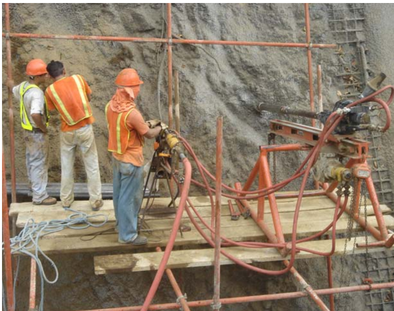
Fig. 3. Perforación sobre andamios
