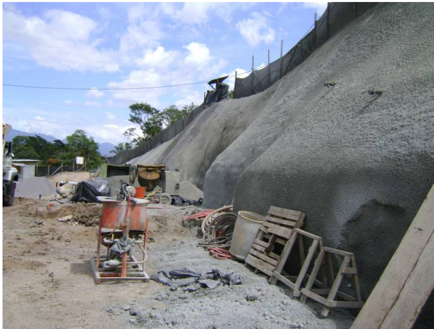
Fig. 4. Acabado de concreto lanzado
