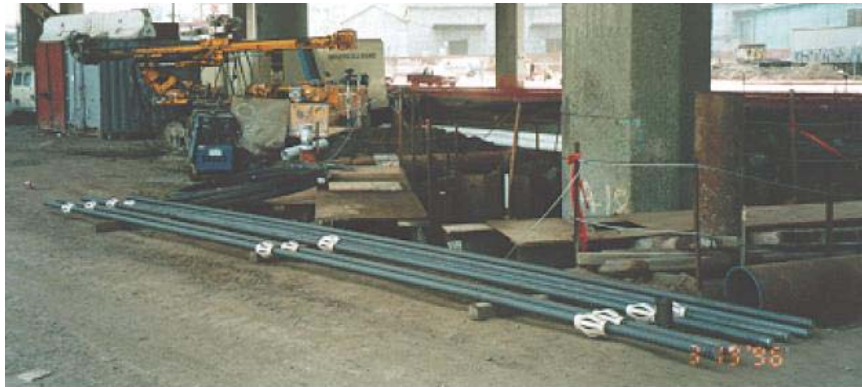
Fig. 3. Pernos con separadores
