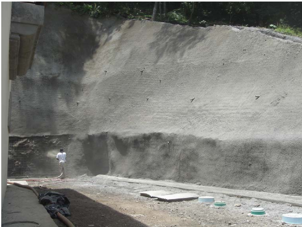
Fig. 1 Soil Nailing en proyecto Residencia Morhaim
