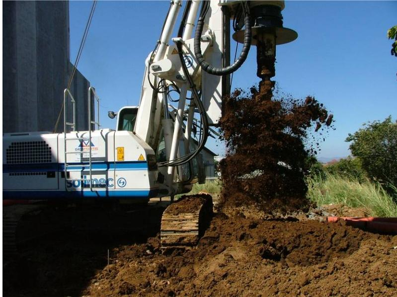
temporal de la perforación. Para tener mayores rendimientos y seguridad en las obras, es recomendable realizar los pilotes utilizando equipos de perforación hidráulicos.
